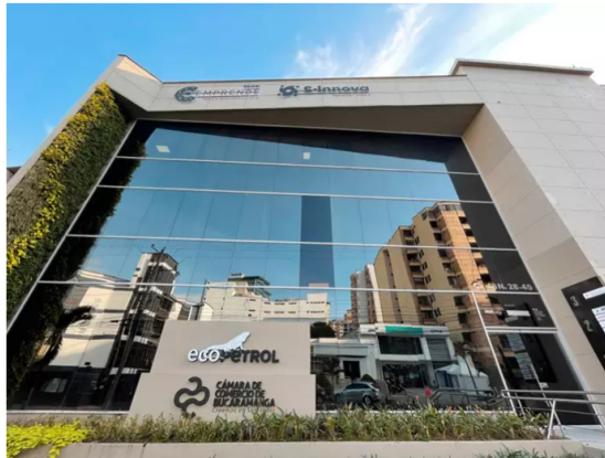
Ecopetrol invertirá un millón de euros en un laboratorio para avanzar en transición energética en Colombia - ECO PETROL
